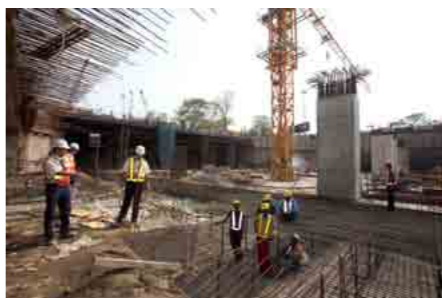
プロジェクトを進めるなかで着実に高まってきたのが、工事現場の安全対策。今では当然のように遂行されている。
