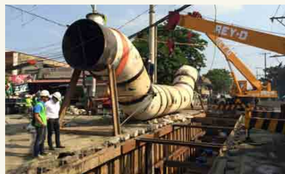
配水途中での水漏れをなくすために、配水管を新しくする。
