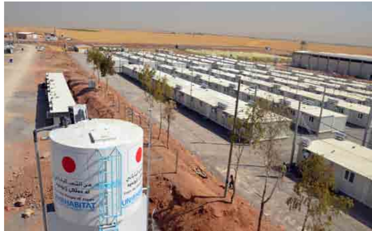
日本の資金で、国連人間居住計画(UN-HABITAT)がイラクで実施した事業で供与されたシェルター(仮設住宅)と給水塔。(写真提供:国連人間居住計画/UN-HABITAT)
